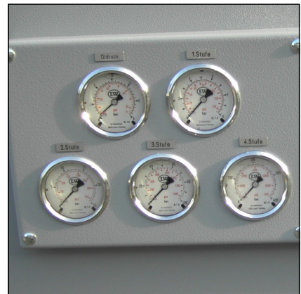
Abb. 2 - Zwischendruckmanometer im LW 720 ES (SILENT Gehäuse)
