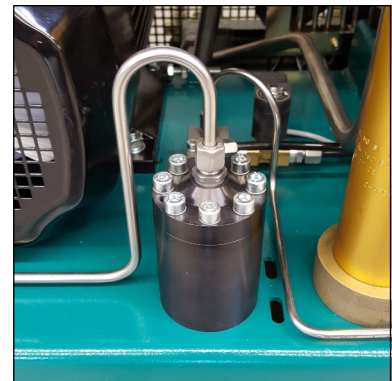
Abb. 1 - Kondensat-Stopp-Ventil-Gehäuse
