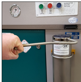
Abb. 2 - Abschrauben des Filtergehäuse-Deckels
