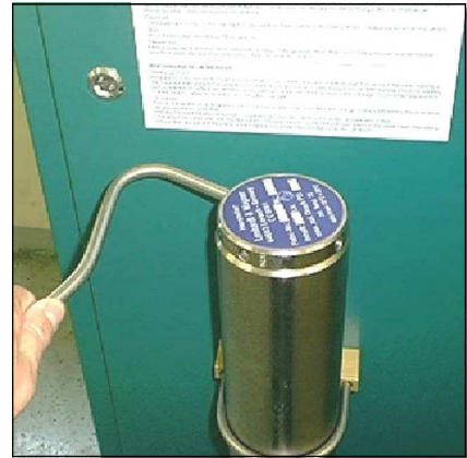
Abb. 1 - Abschrauben des Filtergehäuse-Deckels
