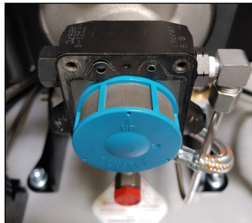
Abb. 2 - Einbaulage Ölsieb
