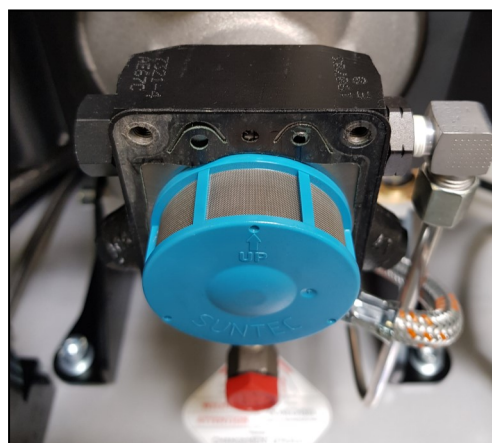
Abb. 2 - Einbaulage Ölsieb
